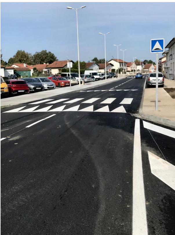
la rue après les travaux
