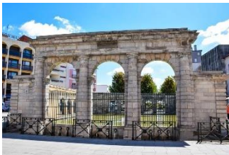
Fontaine d'eau chaude
