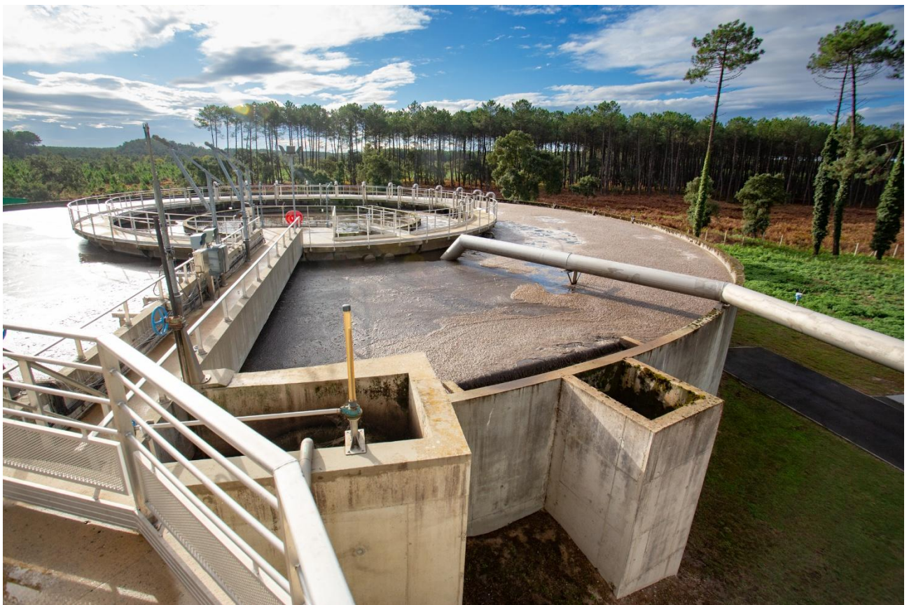
Station d'épuration de SOUSTONS : 100 000 EH
