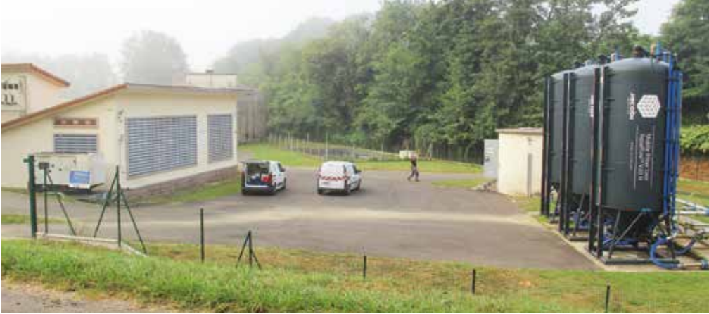
Usine eau potable de Saint Gein
