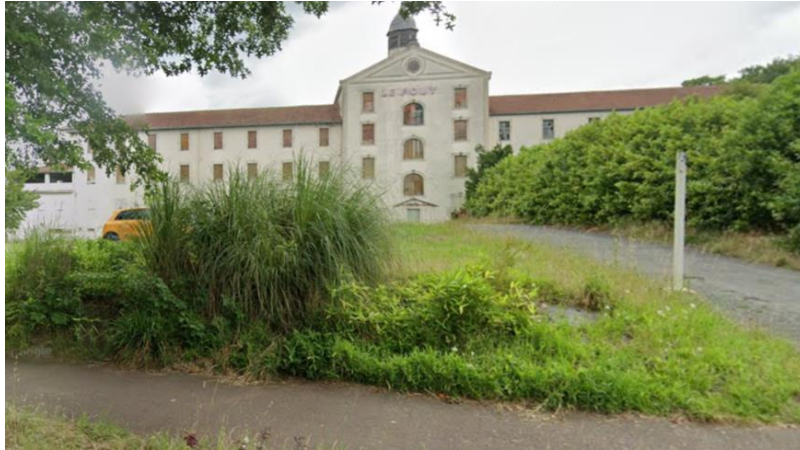
Extrait GoogleMaps – StreetView - Vue du bâtiment du « Pouy » depuis la rue des Lazaristes
