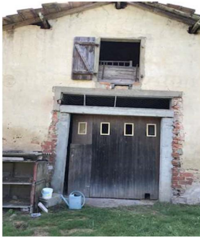
Photo de la grange – Mairie de Rivière-Saas-et-Gourby
