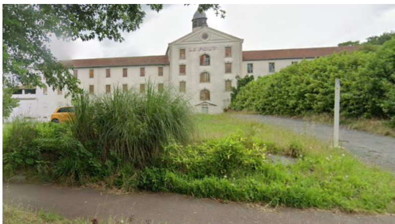
Extrait GoogleMaps – StreetView - Vue du bâtiment du « Pouy » depuis la rue des Lazaristes
