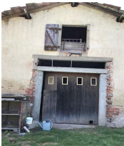
Photo de la grange – Mairie de Rivière-Saas-et-Gourby
