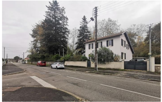
Boulevard du Sarrat, l'entrée du Parc est peu visible.
