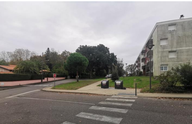
Les immeubles de logement à l'ouest, face au Parc
