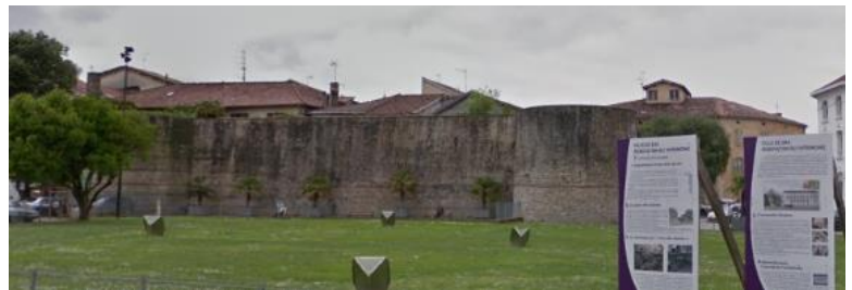
Mur d'enceinte en entrée de ville Source : atelier Lavigne
