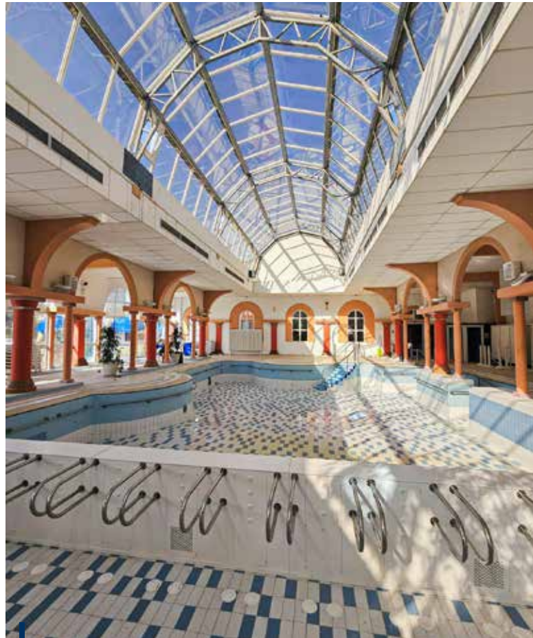
La piscine des Thermes Borda entièrement rénovée.
