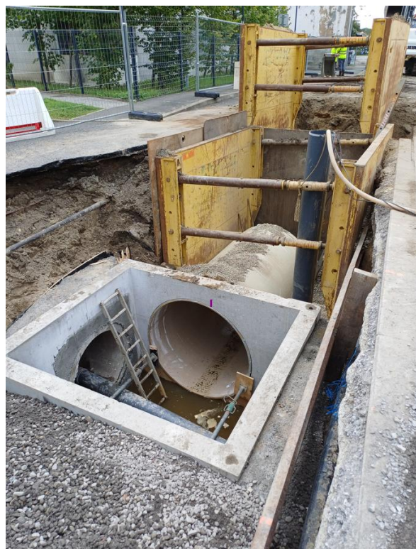
Remplacement de l'aqueduc par une canalisation en PRV DN 1600 mm
